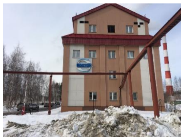
Общий вид здания
