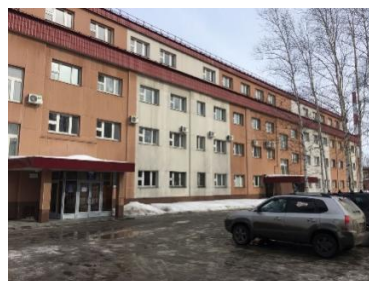
Общий вид здания
