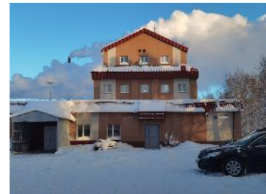
Общий вид здания
