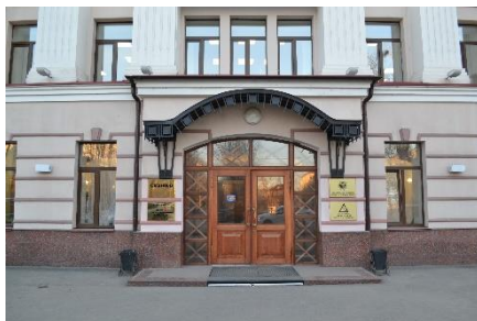
Вход в здание
