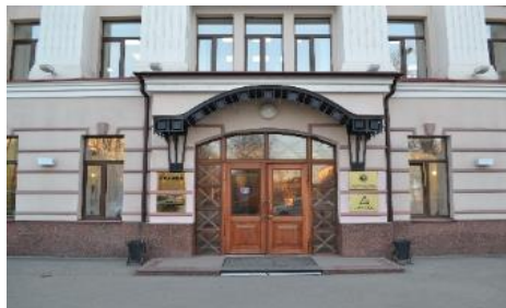
Вход в здание
