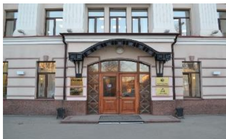
Вход в здание
